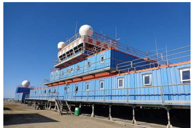
Scatto della stazione di controllo della base Mario Zucchelli, prima di neve
